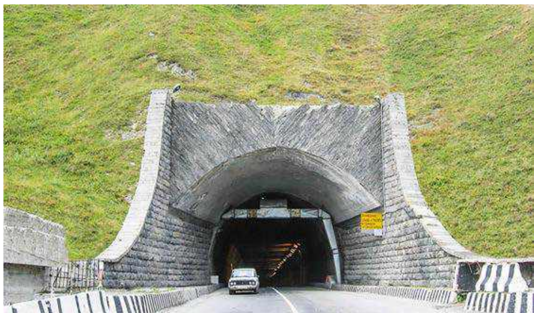
Рукский тоннель, южный портал
